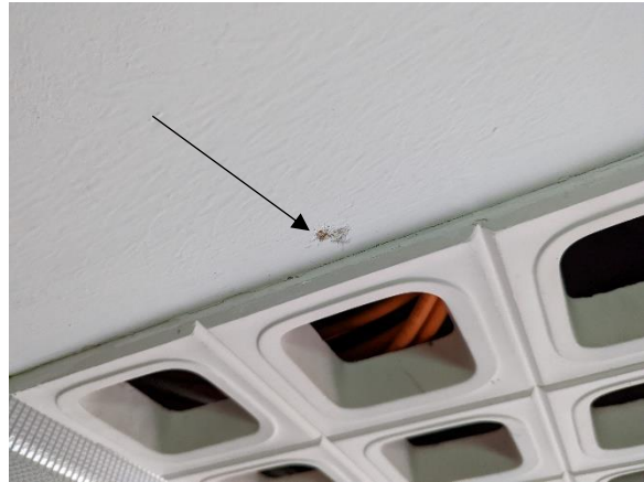
Abb. 5: Probe 2, Beschichtung Randfries, asbesthaltig
