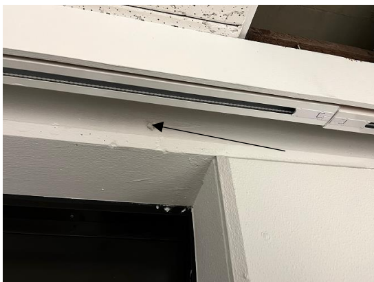
Abb. 25: Probe 23, Raum 302, Unterzug unterhalb Decke, weiß beschichtet mit weißer Spachtelung, asbesthaltig
