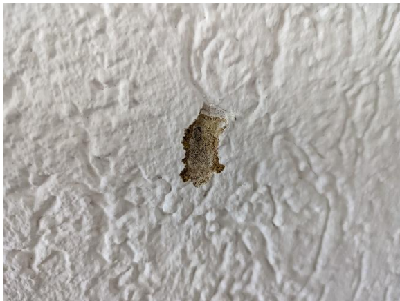
Abb. 14: Probe 11, Strukturwandputz (exemplarisch), ohne Befund
