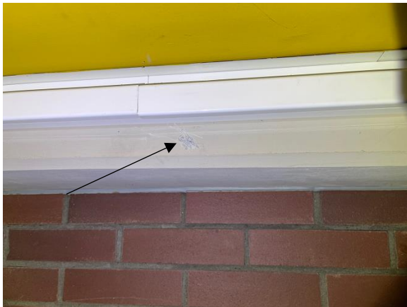
Abb. 17: Probe 14, Flur an Raum 315, Unterzug, beschichtet: ohne Befund
