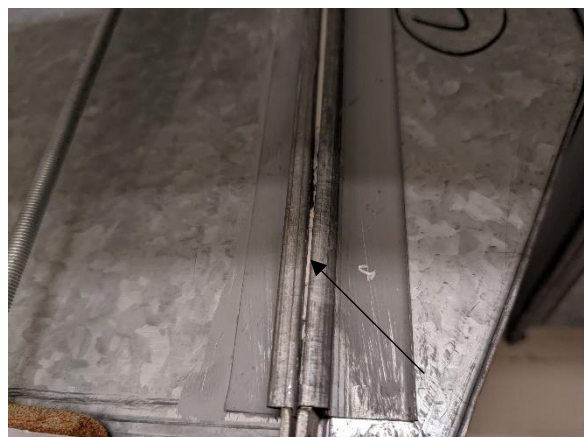
Abb. 9: Probe 6, Dichtung an Lüftungkanalflanschen, ohne Befund
