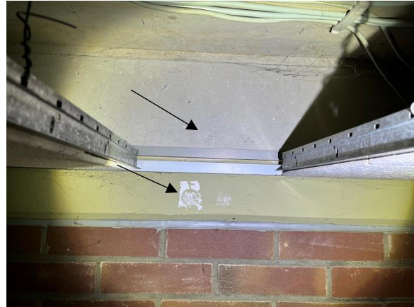
Abb. 22: Probe 19, Raum 316, Unterzug oberhalb Decke, Betonfläche: ohne Befund unterhalb Decke, oliv beschichtet mit weißer Spachtelung, asbesthaltig
