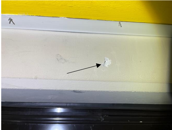
Abb. 21: Probe 18, Flur, Unterzug unterhalb Decke, beschichtete Verspachtelung, asbesthaltig
