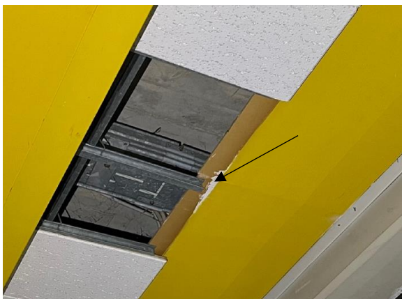
Abb. 19: Probe 16, Flur, Abhangdecke, GK-Randfries, Stoßstelle, Spachtelung: ohne Befund
