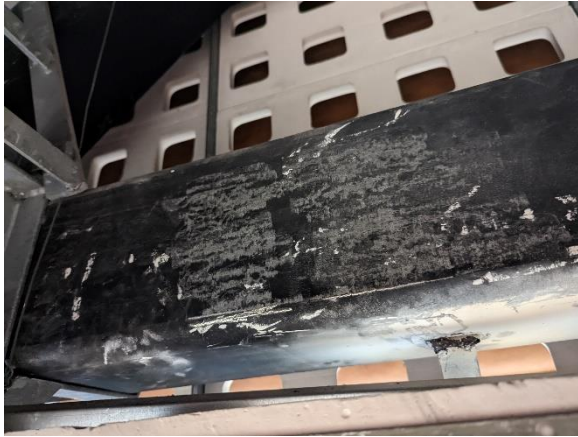
Abb. 10: Probe 7, Beschichtung auf Stahlträger, ohne Befund
