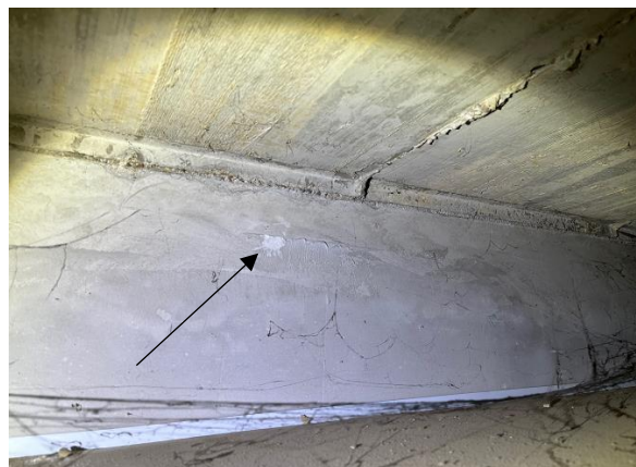
Abb. 20: Probe 17, Flur, Unterzug oberhalb Decke, graue Spachtelung, asbesthaltig
