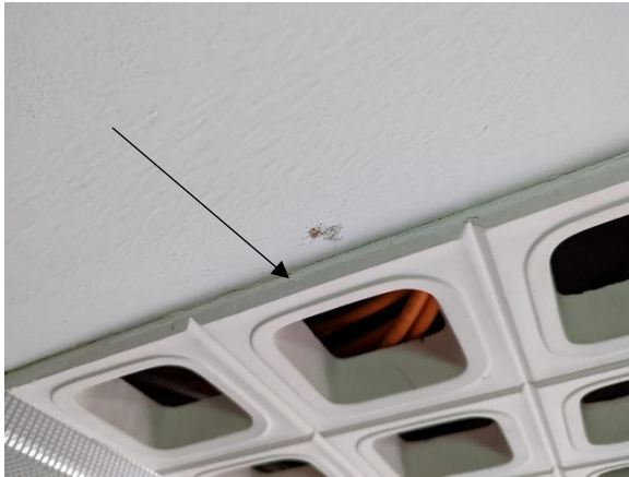
Abb. 4: Probe 1, Fuge Platte/Fries, asbesthaltig
