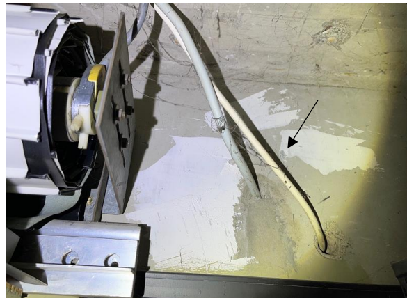
Abb. 24: Probe 22, Raum 316, Unterzug oberhalb Decke, Betonfläche mit weißer Spachtelung, Sprenkern, asbesthaltig
